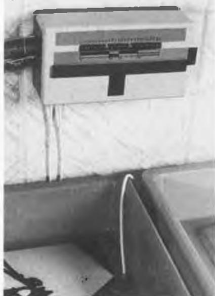
Figure 5. Voici un temporisateur installé au-dessus des baignoires, contre le mur. Le couvercle du boîtier a été doté d'une échelle amovible et les LED sont numérotées.
