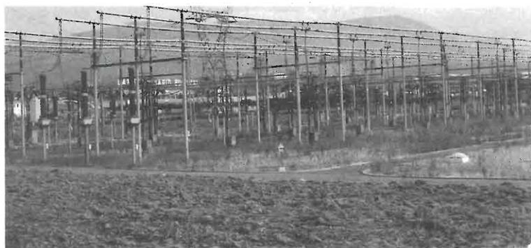
Sbarre alta tensione 380kV con sezionatori a braccio robot (Prato).
