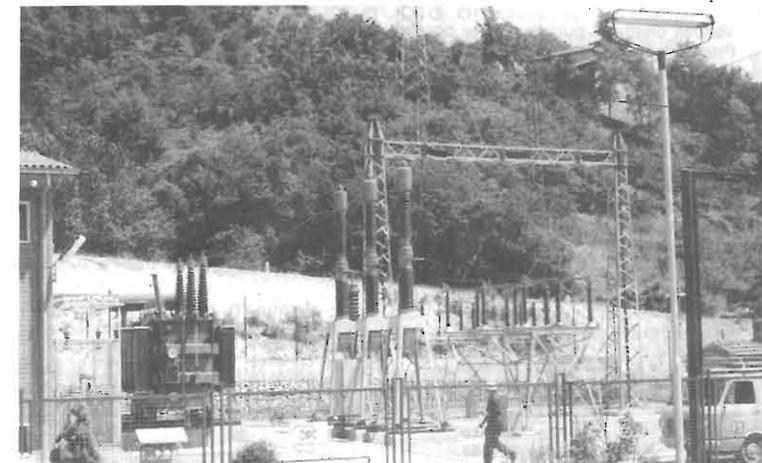
Piccola sottostazione per trazione FS (Vado). Particolare interruttori e trasformatore in olio.
