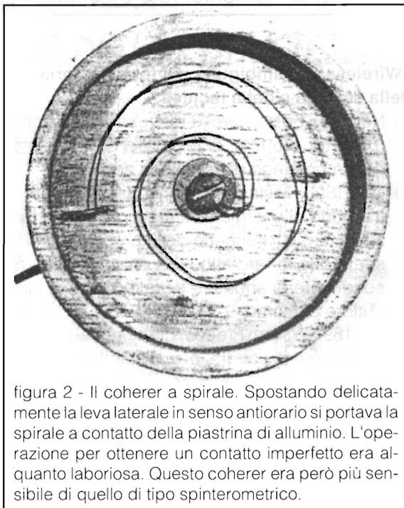
figura 2 - Il coherer a spirale. Spostando delicatamente la leva laterale in senso antiorario si portava la spirale a contatto della piastrina di alluminio. L'operazione per ottenere un contatto imperfetto era alquanto laboriosa. Questo coherer era però più sensibile di quello di tipo spinterometrico.
