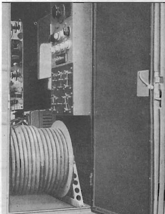
Foto 4 - Vista del portacavo trifase e del quadretto di alimentazione a corrente alternata.
