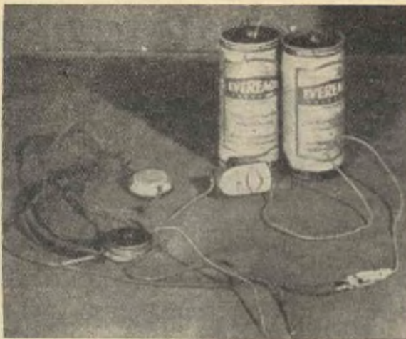
Fig. 4 - Se il circuito è in ordine, nella cuffia si udrà un «click» chiarissimo. Fig. 5 (a sinistra) Anche con le pile può essere usato un campanello. Occorre però usarne di buona potenza
