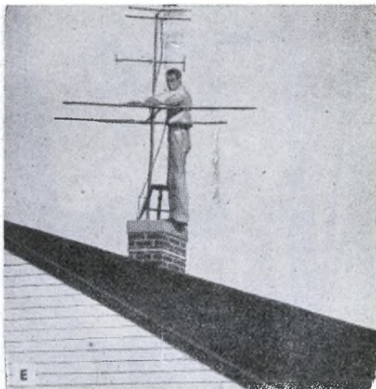
FIG. 23. - Installazione di un'antenna su di un camino: quando il camino consente un solido fissaggio e lo spazio circostante è libero, è il miglior modo per risolvere il problema.
