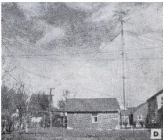
FIG. 22. - Per sfuggire ai disturbi, l'antenna è stata elevata oltre il normale. L'orientamento, lontano dalle trasmittenti, è semplice.
