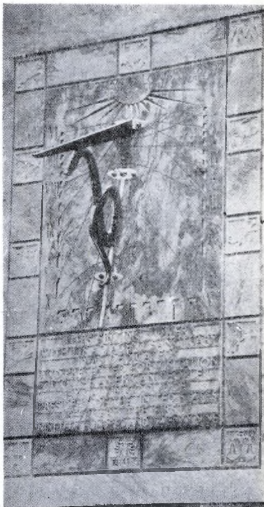
La foto mostra una meridiana verticale a declinazione. Poiché il quadrante declina di pochissimi gradi verso est, la base dello stilo cade tra le ore del mattino.
