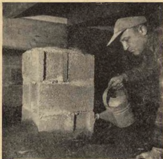
Introdurre l'insetticida anche lungo le file dei mattoni forati, di cui le termiti sono solite avvantaggiarsi per trasferirsi da un punto all'altro, della casa.
