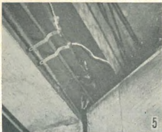
Sistema di rilevamento di allarme per la porta di un garage. Se la chiusura del garage o della rimessa è del tipo a serranda avvolgibile, conviene fare ricorso al sistema del filo a zig-zag, sistemato all'interno.
