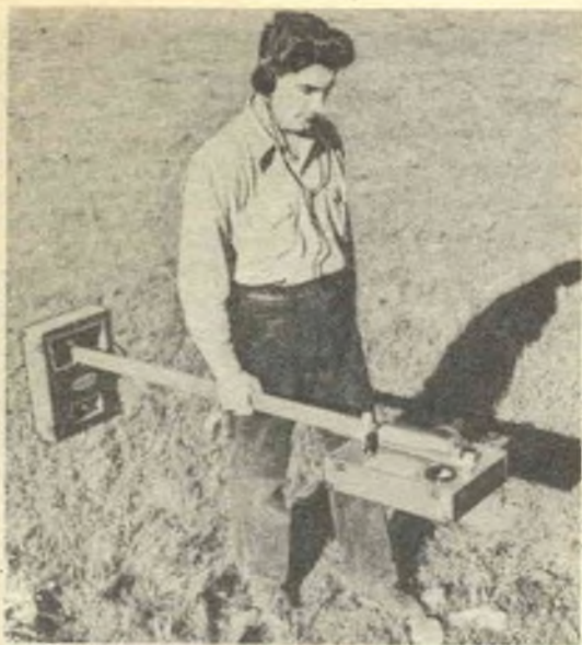
Un'altra versione del cercametallo a trasmettitore e ricevitore, concepita allo scopo di aumentare la distanza tra le due antenne a telaio e quindi rendere più precise le segnalazioni dello apparato
