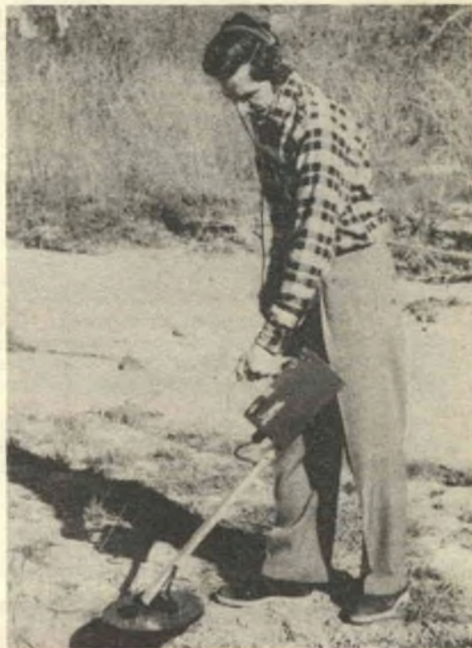
Utilizzazione di un cercametri ad un transistor, come quello illustrato nel n. 28 di «Fare», leggermente modificato per permettere la ricerca al suolo: per mezzo di un bastone è stata aumentata la distanza tra la bobina esploratrice ed il complesso elettronico
