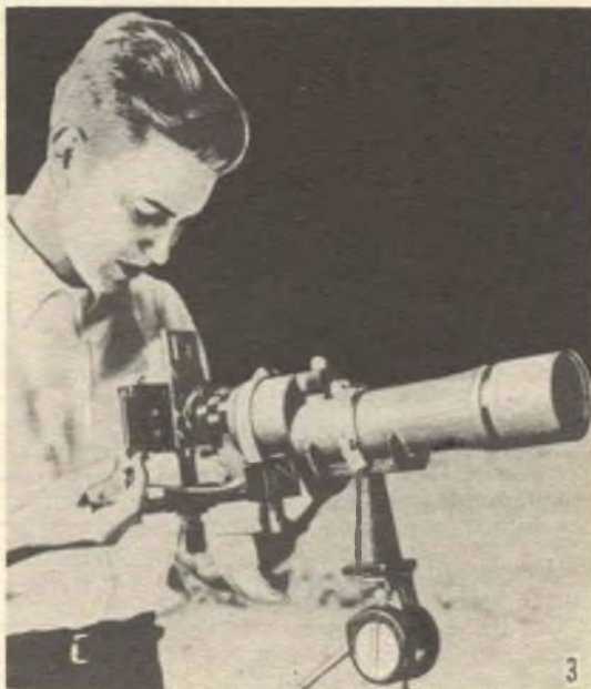
Applicazione di una macchina fotografica, del tipo reflex ad un telescopio prismatico, di produzione giapponese che è possibile trovare presso quasi tutti gli ottici
