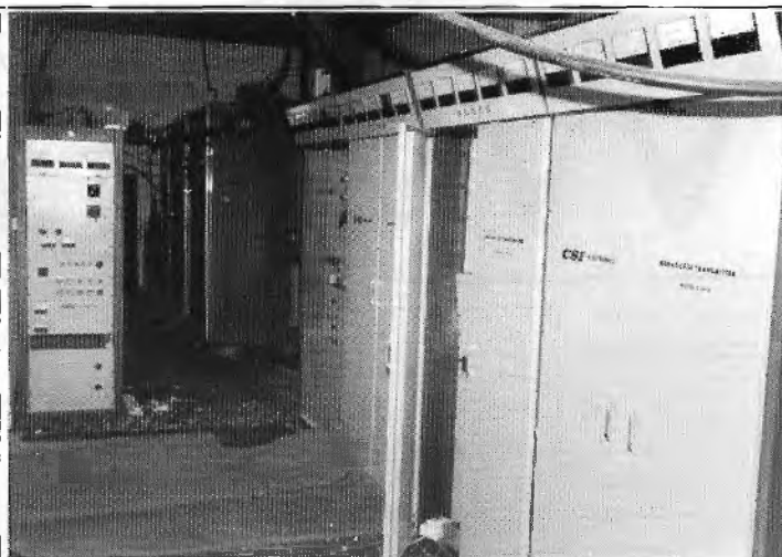
10 KW AM CSI/1 KW AM CSI/ 3 KW FM CSI en 50 KW AM RCA zenders. Links nog een 1 KW FM CSI zender.
