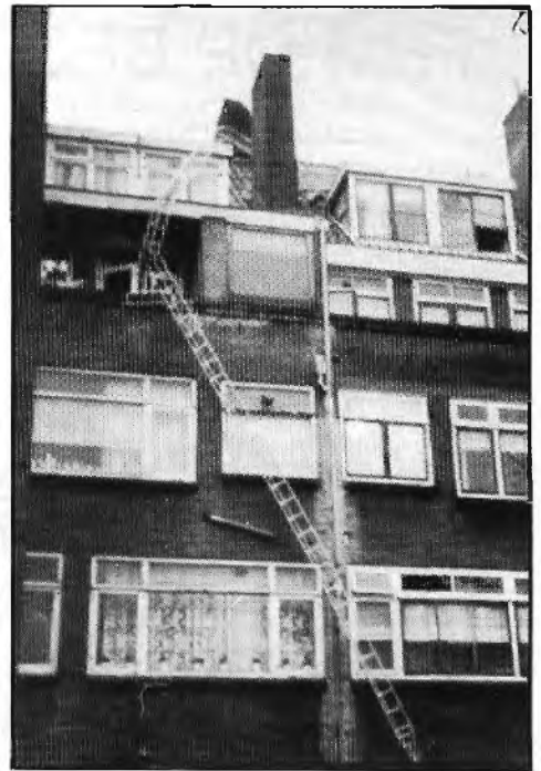
De antennemast is die van onze vriend Paul van Delft, links net geplaatst en vlak voordat hij omwaalde (rechts). De tulen staan hier veel te stijf.
