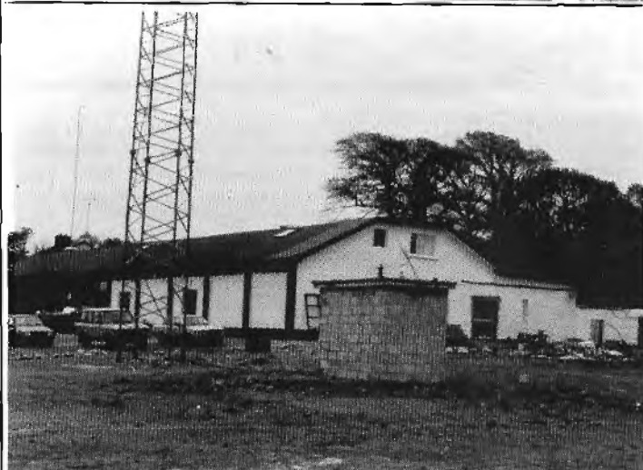
ZENDER/STUDIO COMPLEX MET DE ANTENNE TUNING "HUT" VOOR DE 50 KWATTER.
