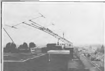
OPRIJZEN VAN DE 30 METER HOGE NIEUWE ZENDMAST
