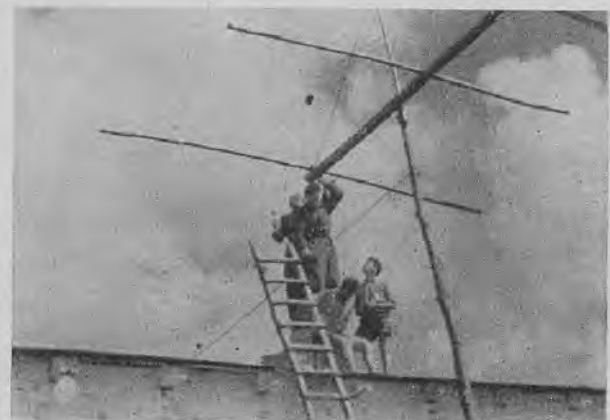
Die Kameraden von DM 3 ML beim Bau eines Mini-Beams.
