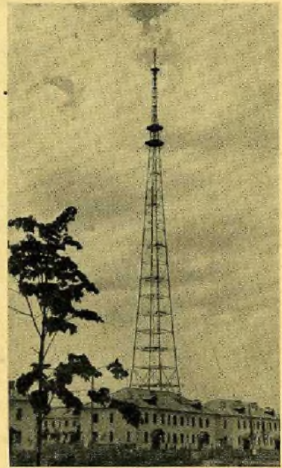
In Kasan (UdSSR) wurden die Montagearbeiten am Bau eines neuen Fernsehentrums beendet. Unser Bild zeigt den Antennenmast mit der Fernsehantenne.
