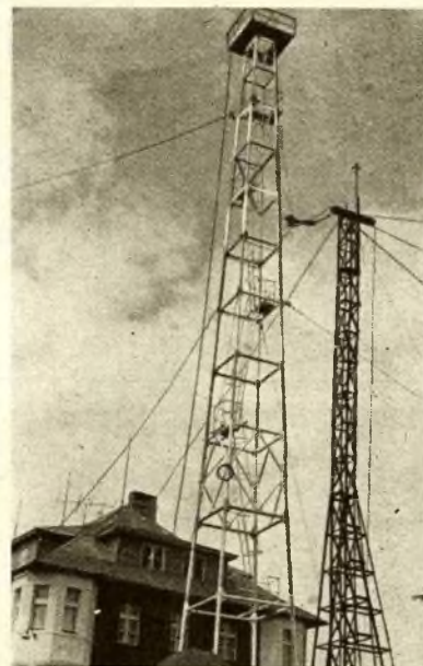
Dieses Foto zeigt die Montage des Stahlrohturmes für die Fernsehantenne. Der Sender selbst steht im Dachgeschoß des Hauses
