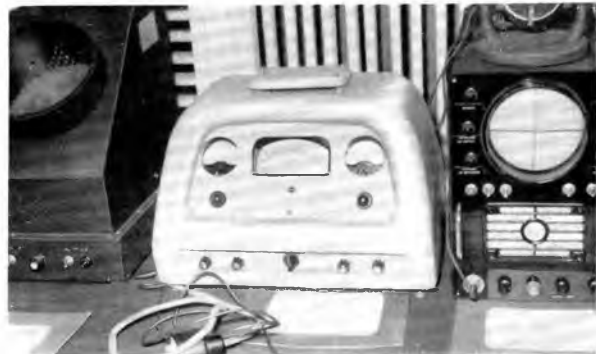
Die Abteilung „Elektronische Medizin“ war sehr stark vertreten. Links vor dem Instrument ein Korrektofon, ein Hilfsgerät zum Abgewöhnen des nervös bedingten Stotterns. Rechts dahinter eine elektronische Sprechhilfe für Menschen, deren Stimmbänder nicht mehr arbeiten
