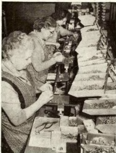
„Die fleißigen Frauen, sie weben und flechten...“, hieß es einst bei unseren Vorfahren. Heute bestückt Oma (im Vordergrund) fleißig Leiterplatten für „Babys“ mit funktechnischen Bauelementen
