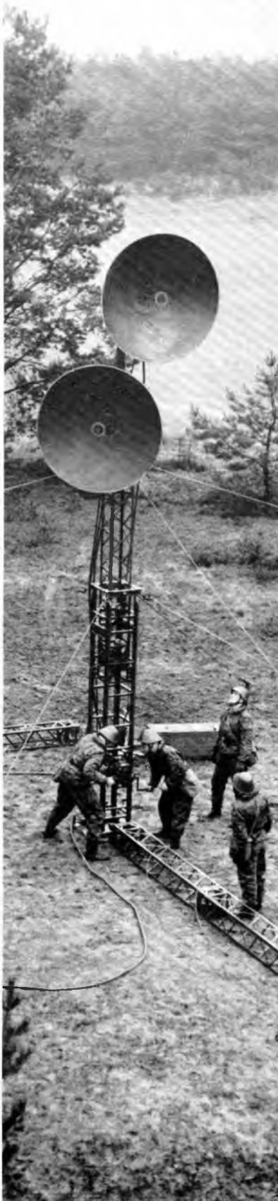
Links: Der Antennenmast für eine Richtfunkstrecke wird aufgerichtet
