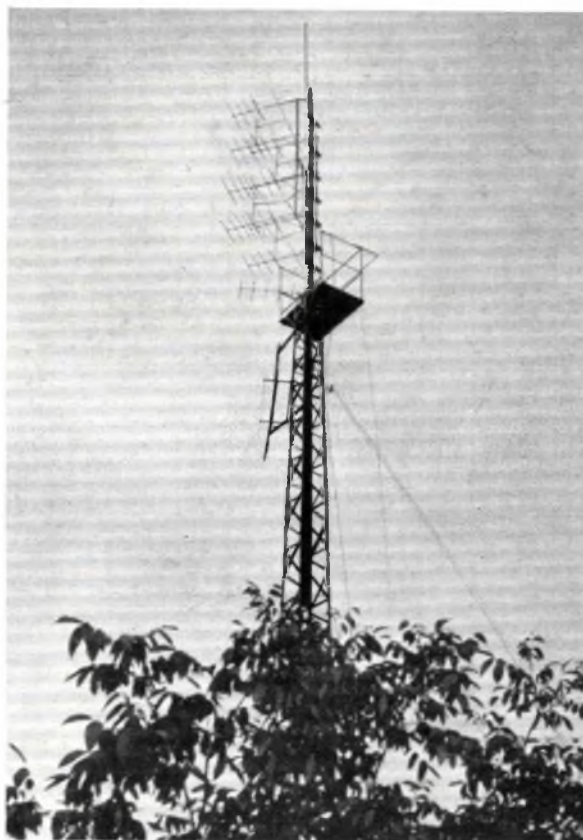
In einer Höhe, die etwa sechs Stockwerken entspricht, drehen sich die UHF- und TV-Antennen von HA 0-004 auf einem selbstgebauten Turm. Gyula Nagy aus Hajdunahas empfängt damit Sendungen aus aller Welt, Bild oben
