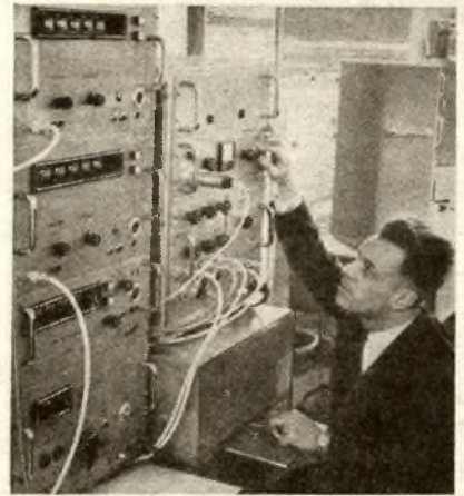
Eine Meßanlage für niedrigste Radioaktivitäten zeigte der westdeutsche Betrieb Friesecke & Hoepfner GmbH aus Erlangen Bruck
