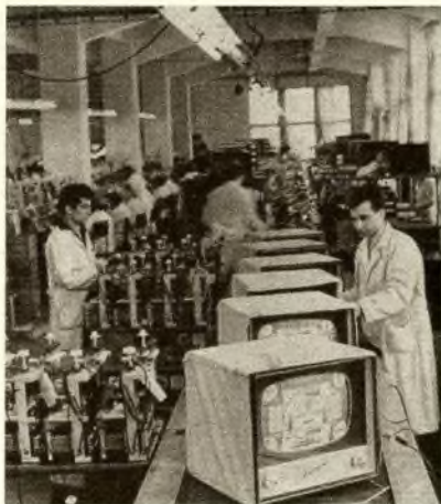
Ein Blick in das Sofioter Schwachstromwerk für Elektroapparate, in dem auch die Fernsehgeräte vom Typ „Opera“ hergestellt werden
