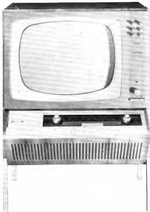
Als Kombination für den Rundfunk- oder den Fernsehempfang stellte sich das Standgerät „Clarissa II“ vor. Es enthält einen Fernsehempfänger mit 53-cm-Bildröhre und das Rundfunkchassis „Saalburg“ für UKW, KW, MW und LW. Für das Rundfunkgerät, das klappbar angeordnet ist, ist ein zusätzlicher Lautsprecher eingebaut (VEB Fernsehgerätekwerke Staßfurt)
