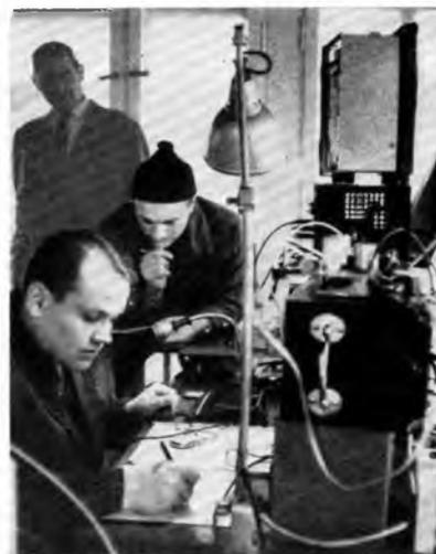
Bild 1: Gespannt lauschen OM Pricks (DM 2 AKD), vorn links, und OM Damm (DM 2 AWD), dahinter, auf die Signale des Ballonsenders. Die Auszählung der Tonstufen ergab die jeweiligen Höhenwerte des Ballons
