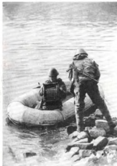
Die Leitung muß einen Fluß überqueren. Natürlich darf für solche Zwecke nur einwandfrei isoliertes Kabel verwendet werden. Das Kabel wird mit Flußgewichten oder Steinen versehen, die es auf Grund halten sollen. Der Trupp hat die Leitung am Flußufer abgebunden. Bald wird er zum anderen Ufer paddeln
