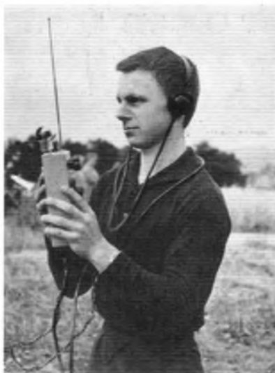
Bild 2: Deutscher Meister in der Fuchsjagd (Klasse A – Jugend) wurde Gerhard Piater aus Cottbus. Er erreichte mit seinem selbstgebauten Fuchsjagdempfänger die vier Füchse in 126,5 min
