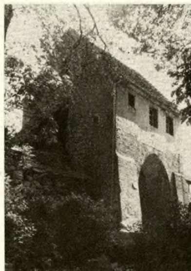
Stationsgebäude, im NAW aufgebaut Foto: Braun
