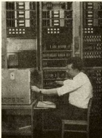
Bild 4: Prüfarbeiten am zentralen Schaltfeld der elektronischen automatischen Telefonzentrale (EATZ)
