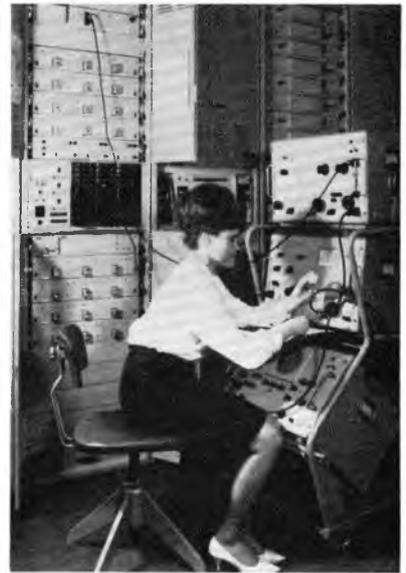
Hier erfolgt im VEB Fernmeldewerk Bautzen die Einmessung eines Amtes vom Trägerfrequenz-System Z 12 V 24. Das System ist volltransistorisiert
