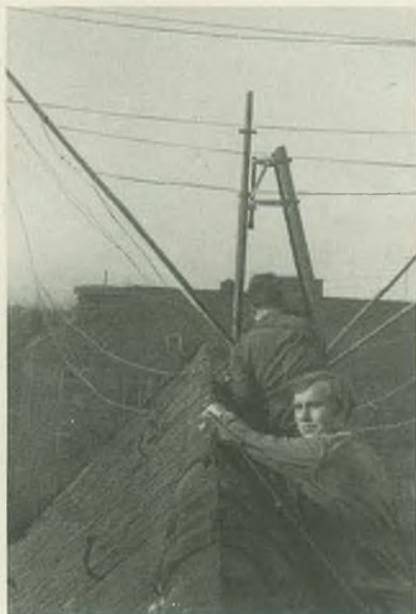
**Bild 6: Die oberen Tragegängen werden am Herzstück befestigt**
