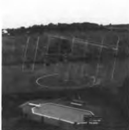
Eine ähnliche Antenne wie die von WSUN gehört KB8RO. Auch hier erfolgt der azimutale Antrieb durch eine im Kreis fahrende Zugmaschine.
