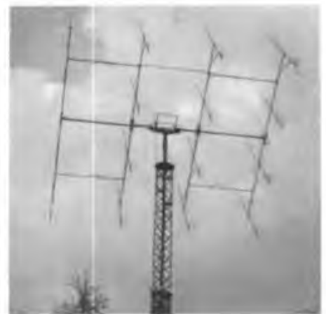
16 14-Element-Langyagis und 2 Stück 4 CX 1000 A als Endröhren im Gegentakt ergeben bei DL8 DAT eine für Europa überdurchschnittliche EME-Anlage.
