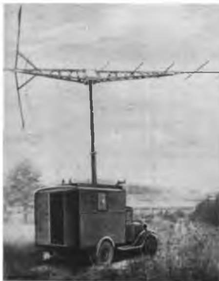
Die mobile Impulsfunkmeßstation „Redoute“ (oben). Sie wurde im Juli 1940 als RUS-2 in die Bewaffnung aufgenommen.
