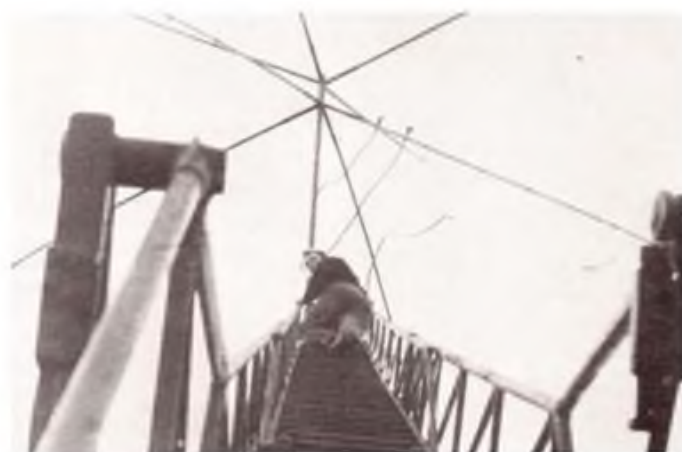
Bild 2: Der Aufwand bei Reparaturen für die alte Bambusquad ist unverkennbar. Ein Drahtbruch im oberen Teil der 14-MHz-Elemente bedeutet nahezu das Aus!
