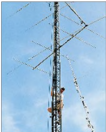
Errichten der 80-m-Antenne von V47KEP auf St. Kitts
