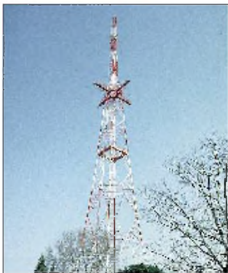
Antennenmast des Mittelwellensenders der RAI in Udine/Italien
