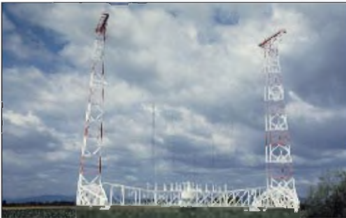
Die drehbare Vorhangantenne, geeignet für 500 kW Sendeleistung
