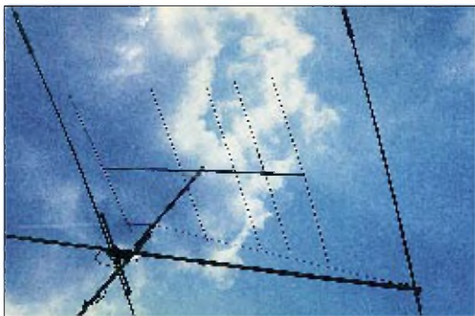
Bild 8: Die beschriebene Antenne auf dem Dach
