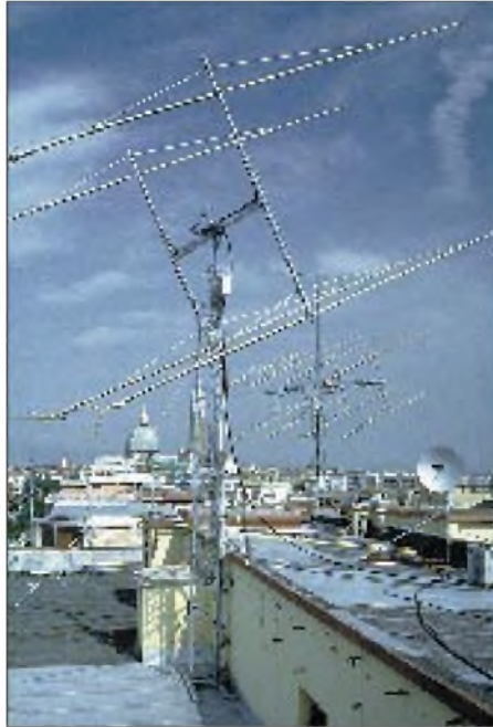
Auf dem Dach bei IW5AVM in Grosseto. Im Vordergrund die 9,15 m langen Shark-Larets für 2 m, im Hintergrund die 16er-Gruppe für 70 cm. Fotos: I4YNO
