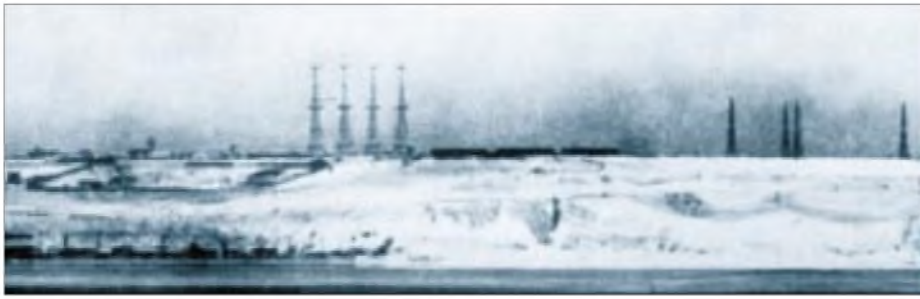
Das Bild zeigt den Blick einer deutschen Fernkamera von Calais nach Dover: links die Sendetürme, rechts die Empfangstürme Fotos aus: K.-O. Hoffmann, Die Geschichte der Luftnachrichtentruppe, Neckargmünd 1968 (2)
