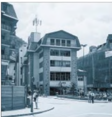
Das Gebäude des Senders „Servei de Telecomunicacions D' Andorra“
