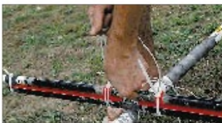
Die Einspeisung des Mosley-Beams: Die fehlenden Isolierstücke und U-Bügel wurden durch Isolierband und Kabelbinder ersetzt.
