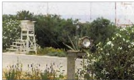
UV-Meider rund um die Mittelwellenantenne sorgten dafür, daß der Sender automatisch kurzzeitig „heruntergefahren“ wurde, wenn sich ein Lichtbogen bildete.
