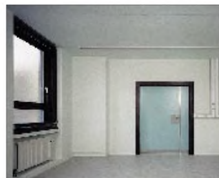
... und nach dem Innenausbau. Die Schirmung ist unter der Rohfaser-Übertapezierung nicht mehr sichtbar.
