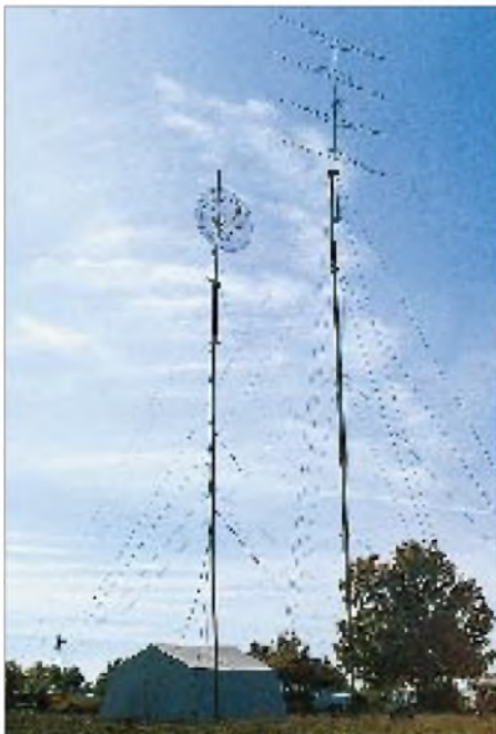
Die Antennen von DL0UL/p für 70 cm und 23 cm im IARU-UHF/SHF-Contest 1995
