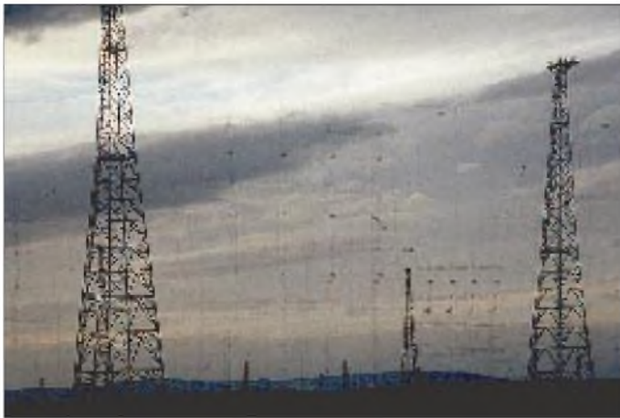
Teilansicht der Vorhangantennen in Emirler etwa 40 km südlich von Ankara – Standort eines 500-kW-SSB-Senders der „Stimme der Türkei“
