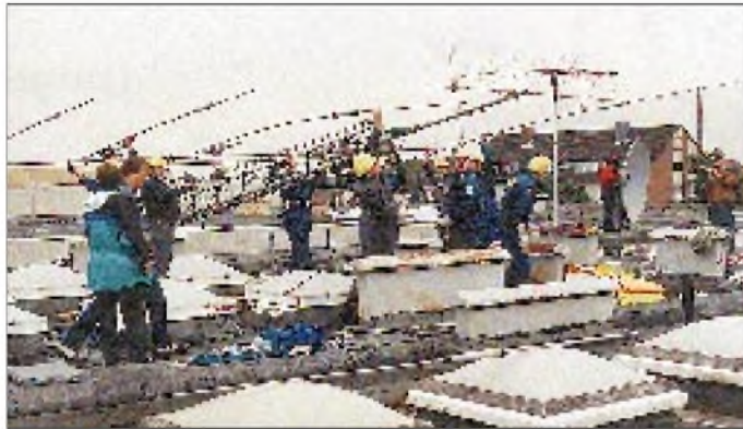
Blick auf das Flachdach des Schulzentrums Harsum: Neben dem 2-m-Spiegel (rechts im Bild) und der 2-m/70-cm-Kreuzyagi für Satellitenaktivitäten verfügt die Schulstation DK0SOM nun auch über einen 5-Element-Kurzwellenbeam.
