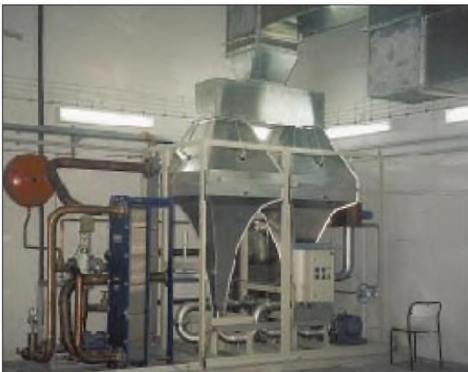
**Dummy-load (künstliche Antenne) für einen 500-kW-Sender**
