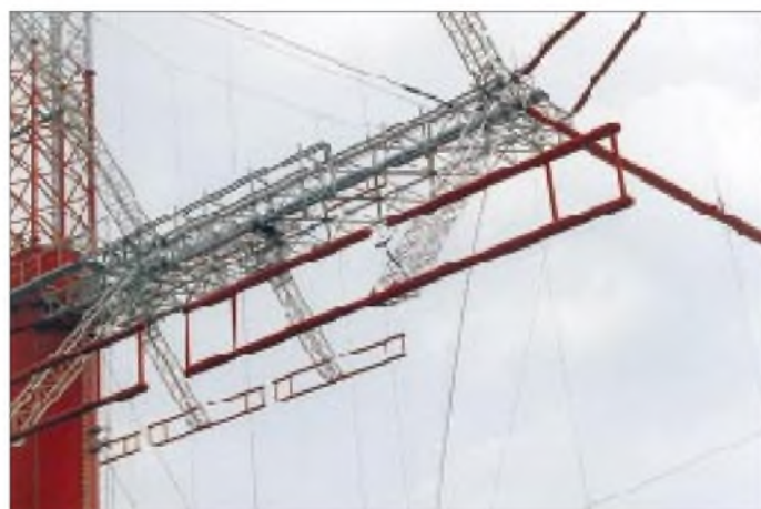
Nahaufnahme eines 15 m breiten Dipols für den unteren Frequenzbereich. Die Drahtseile für die Einspeisung laufen parallel zum Befestigungselement.
