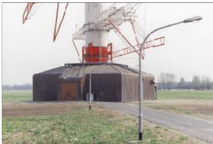
Nahaufnahme eines 15 m breiten Dipols für den unteren Frequenzbereich. Die Drahtseile für die Einspeisung laufen parallel zum Befestigungselement.
