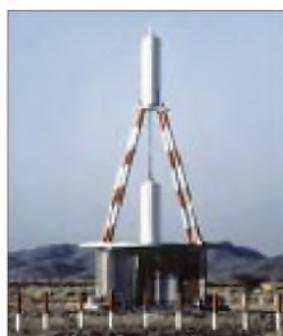
Das Foto zeigt eine VOR-Sendestationen (VHF-Omnidirectional-Range). Mit Hilfe von UKW-Drehfunkfeuern wird Flugzeugen der richtige Weg gewiesen.
