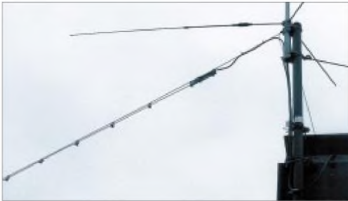
Bild 4: Die liegende 6-m-J-Antenne unterhalb der 6-m-GP bei DJ3RW
