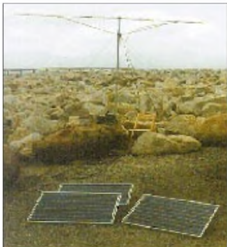
Die zur Pufferung der Akkus eingesetzten Solarzellen (Nennleistung 3 x 53 W) lieferten auf dem Harzgipfel gegen Mittag je nach Bewölkung zwischen 10 und 200 W).
