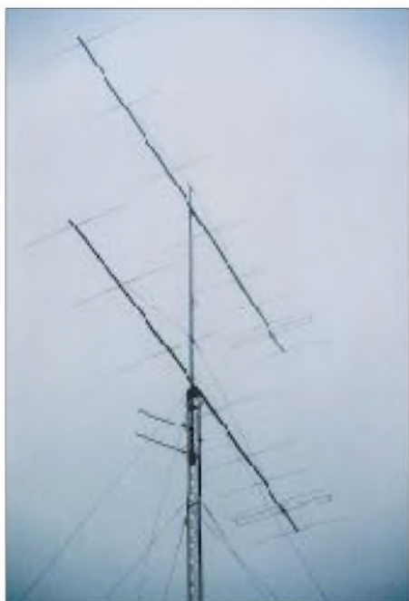
2 x 9-Element-Yagi in 40 m Höhe – hier im Nebel Fotos: DL7AV
