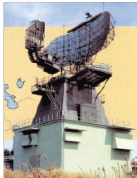
Thomson-CSF Ares 3D-Radar – ursprünglicher Bestandteil des NADGE
