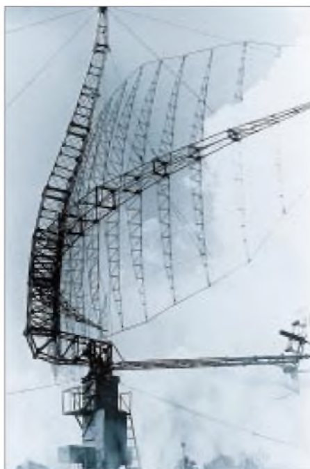
Meterwellen-Station P-14F zur Fernaufklärung: Die Parabolantenne ist 32 m breit. Die Antennenabspannungen sind zur Verhinderung von Eisablagerungen beheizbar.
