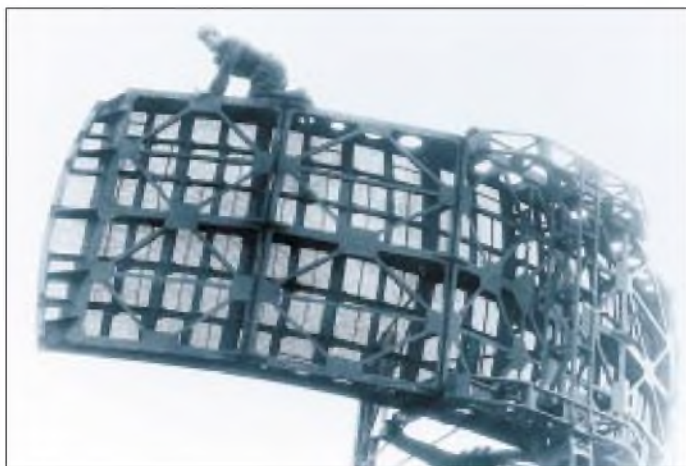
Antenne der Zentimeterwellen-Funkmeßstation P-25, einer Jägerleit- und Aufklärungsstation der 50er Jahre
