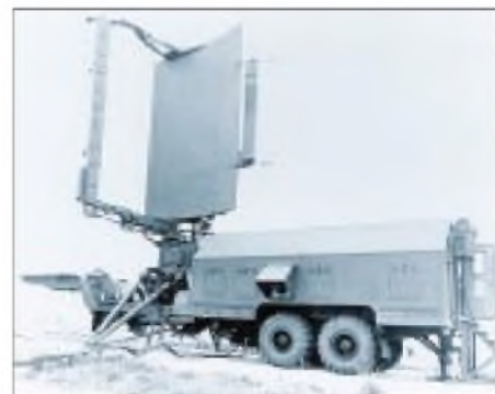
Störgeschützt, mobile 3-D-Funkmeßstation ST-68U, die die Warschauer Vertragsstaaten in den 80er Jahren zur Ortung von Cruise Missiles einführt.
