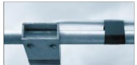
Bild 2: Befestigung der Elemente und der Phasenleitungen
