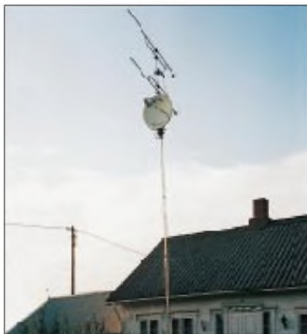
Antennenanlage von LA/DB1DI/p – vor dem Sturm in voller Höhe
