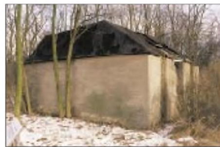
Die Betonsockel des ehemaligen Mittelturms erreichen beinahe die Größe eines Einfamilienhauses.
