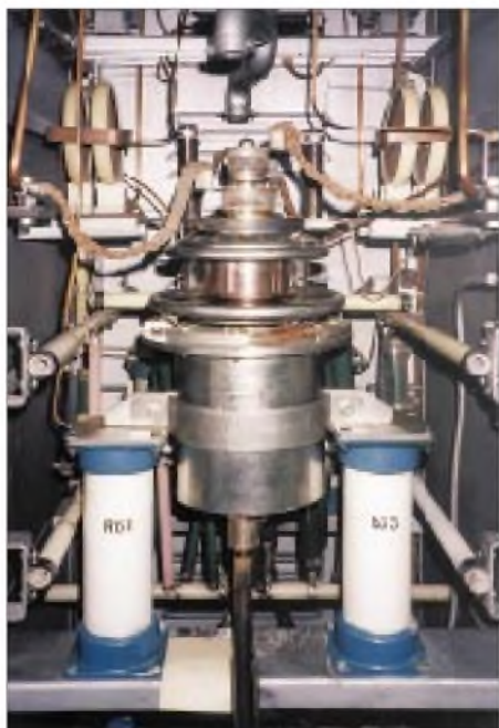
Die Endstufenröhre des Senders 23
