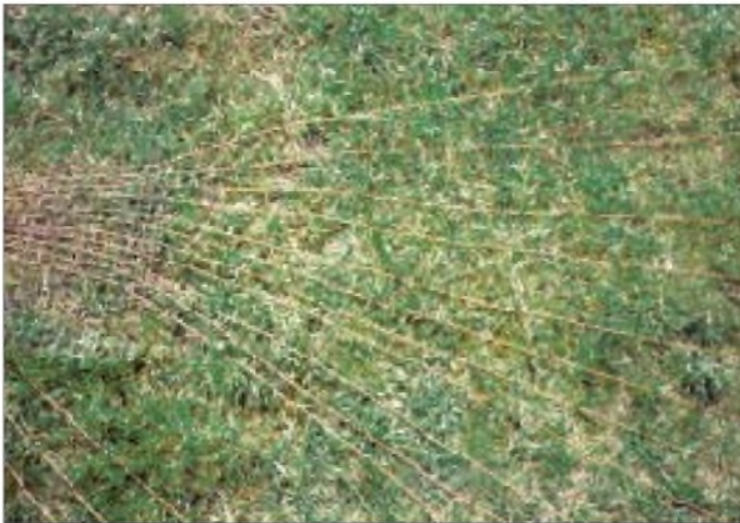
Um die Radials z.B. zum Rasenmähen bequem aufnehmen und wieder geordnet verlegen zu können, wurden die einzelnen Drähte durch „Kaninchengitter“ gefädelt.
